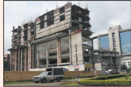
বিজ্ঞান ও প্রযুক্তি কমপ্লেক্স স্থাপন প্রকল্পের ভৌত অবকাঠামোর উন্নয়ন কাজ
